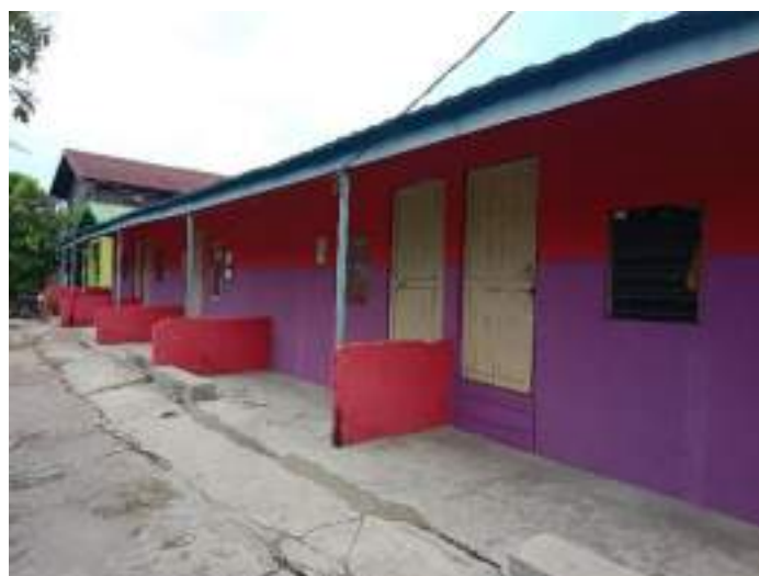
Gambar 5. 78 Rumah Sewa Deret
