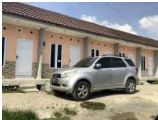
Gambar 5. 32 Rumah Sewa Deret
