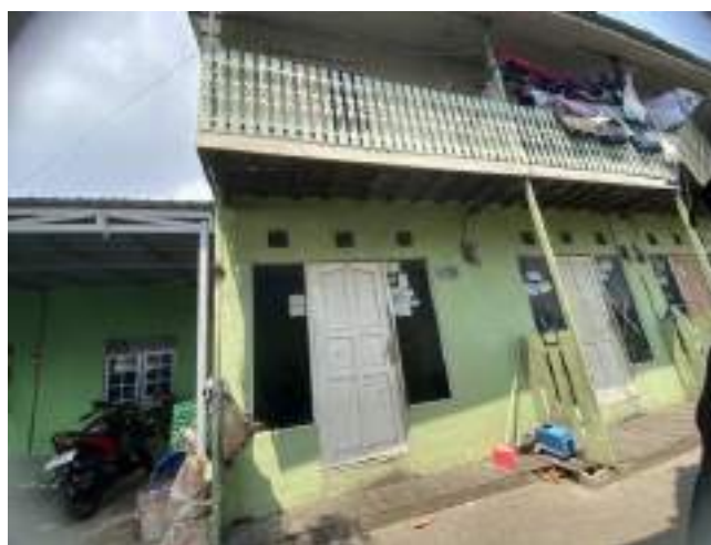
Gambar 5. 72 Rumah Sewa Deret
